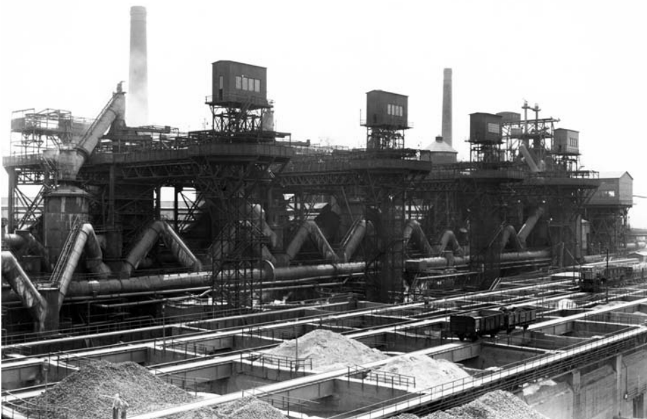
Abbildung 21: Hochofenanlage mit neuem Hochofen 5 (rechts hinten). Er bekam im Gegensatz zu den bisherigen Öfen einen sogenannten Schrägaufzug, 1954, Quelle: ThyssenKrupp Konzernarchiv Duisburg
